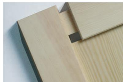
Assemblage par tenon et mortaise
