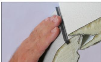
Les panneaux isolants anti-pince-doigts de **PORTMATECH** ont une épaisseur de 40 mm, disponibles en hauteurs de 500 ou 610 mm, composés de deux tôles d'acier galvanisés laqués en polyester, séparés par une mousse isolante rigide de polyuréthane de haute densité sans HFC et HCFC, lui permettant d'avoir un haut coefficient d'isolation thermique et phonique.
